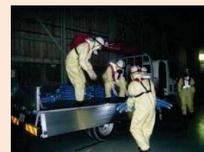
可搬型の窒素ガス発生設備用のホースをユニック車に積み込んでいる様子
