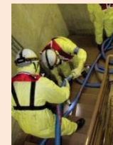
ホースを原子炉建屋内に敷設している様子
