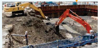
掘削工事の様子
