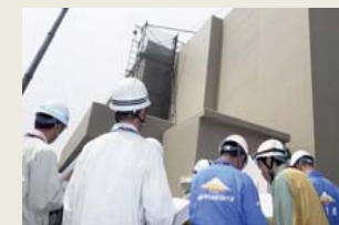
海水熱交換器建屋構造強化工事点検の様子
