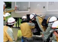
②ケーブルを接続している様子
