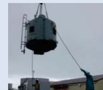
②モータをクレーンで吊り上げる様子
