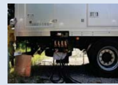
③ケーブルを接続した状態
