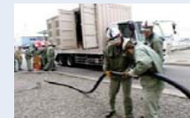
電源車へのケーブル接続訓練
