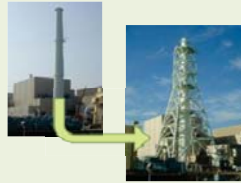
Ⓑ排気筒補強工事
