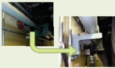
Ⓐ配管サポート工事
