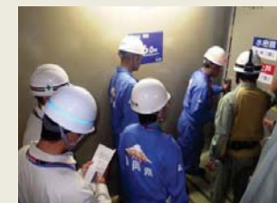
建屋外壁扉への自動閉止装置の設置工事点検の様子
