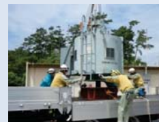
①予備のモータをトラックにて運搬後、クレーンに繋ぐ様子
