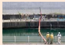
シルトフェンスを設置する様子
