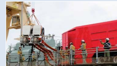
ポンプをクレーンで吊り上げている様子
