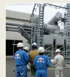
受電用変圧器高台設置工事点検の様子
