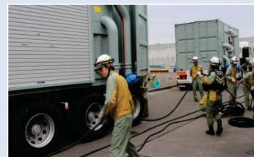
代替熱交換器へ電源ケーブルを引いている様子
