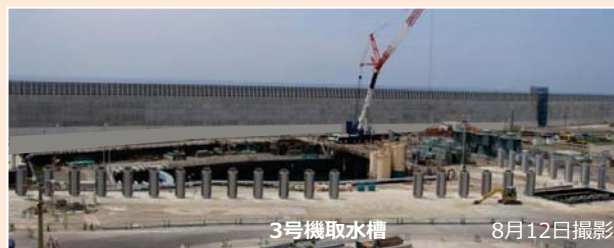
3～5号機溢水防止壁設置工事の様子
