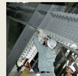
防波壁設置工事点検の様子
