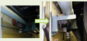
Ⓐ配管サポート工事
