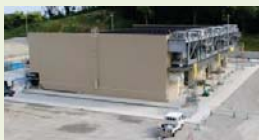
Ⓔガスタービン発電機建屋
