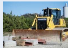
がれき撤去訓練
