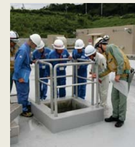
緊急時淡水貯槽設置工事点検の様子
