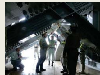
防波壁設置工事点検の様子
