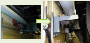
Ⓐ配管サポート工事
