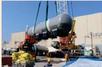
吊り込み中の様子
