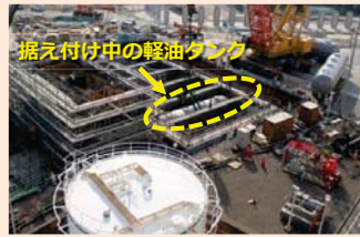
据え付け作業の様子
