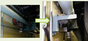
Ⓐ配管サポート工事
