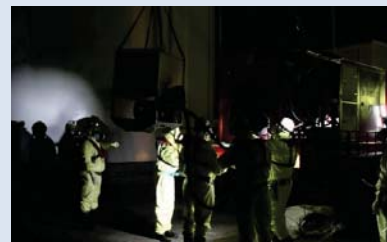
取水ポンプ車から水中ポンプを降ろしている様子
