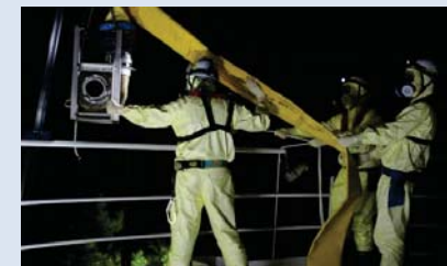
水源タンクへ水中ポンプを吊り上げている様子
