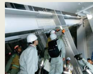
防波壁設置工事点検の様子 (防波壁放水路部にて)
