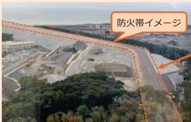
西側改良盛土
