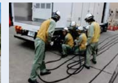
電源車へのケーブル接続訓練
