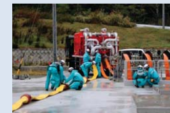
③注水ポンプ車へホースを繋いでいる様子
