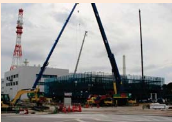
緊急対策所設置工事の様子
