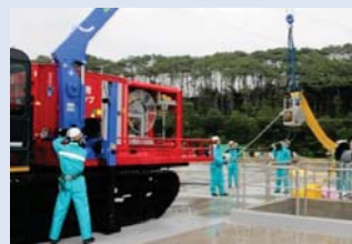
①取水ポンプ車から水中ポンプを投入する様子
