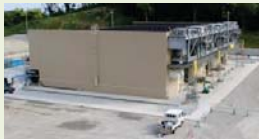
⑤ガスタービン発電機建屋
