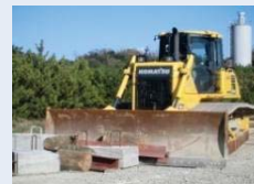
がれき撤去訓練
