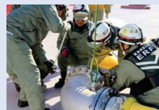
②ホースを接続している様子
