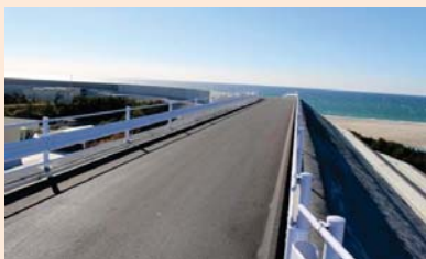
西側盛土頂部
