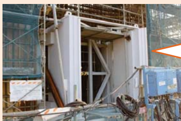
緊急時対策所1階の出入口扉
