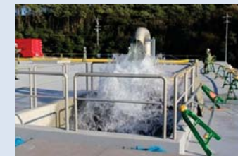
③戻し配管からマンホールへ放水している様子
