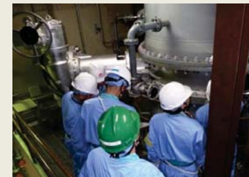
循環水系からタービン建屋内への溢水防止対策（隔離機能の追加）点検の様子
