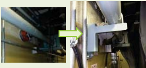
④配管サポート工事
