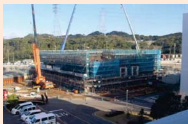
緊急時対策所設置工事の様子
