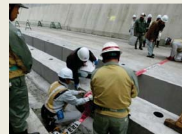
防波壁設置工事点検の様子
