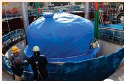
据付工事の様子 (フィルタベント室への吊り下げ)
