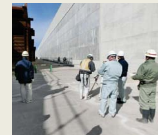
防波壁設置工事点検の様子
