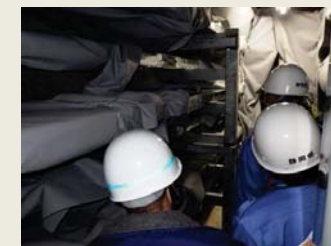
配管・電路類サポートの改造工事点検の様子
