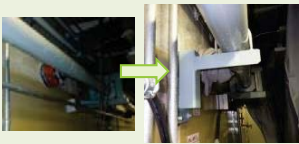
④配管サポート工事
