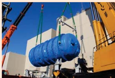
据付工事の様子
