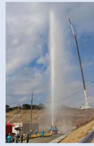
放水砲実放水訓練の様子
