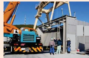
5号機車両ゲートの様子
