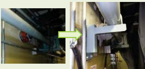
④配管サポート工事
