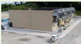
⑤ガスタービン発電機建屋
