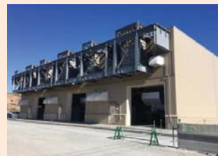
ガスタービン発電機建屋
