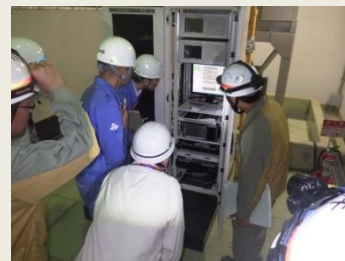
免震構造物への地震観測装置 設置点検の様子
