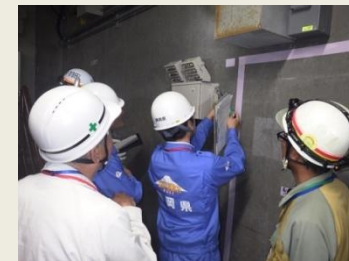
建屋内照明確保のための電源内蔵 非常用照明追設点検の様子
