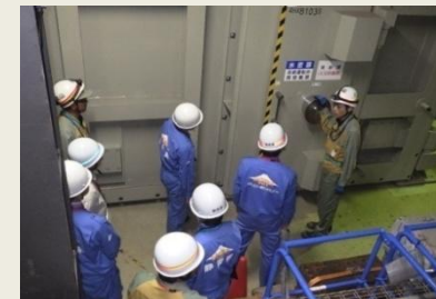
海水熱交換器建屋水密扉の 追設・補強工事点検の様子
