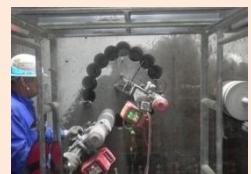
原子炉建屋貫通部工事の様子 (H26.7の写真【H27.9全7ヶ所完了】)
