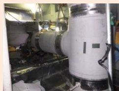
既設配管とフィルタベント配管の接続部
