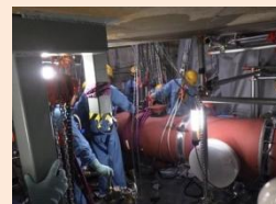
既設配管とフィルタベント配管の接続部
