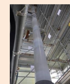
排気筒に設置した配管
