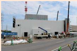
○緊急時対策所の増築
