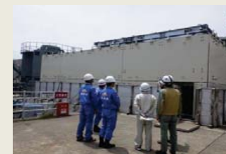
竜巻対策 (海水取水ポンプおよび同ポンプ周辺の配管に対する飛来物防護対策) 点検の様子
