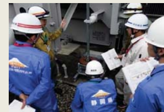
変圧器一相解放対策点検の様子
