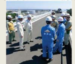
発電所敷地東側西側盛土の嵩上げ 点検の様子
