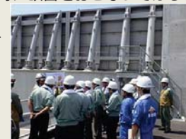
防波壁 現場確認の様子
