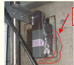
剥離が確認された埋込金物
