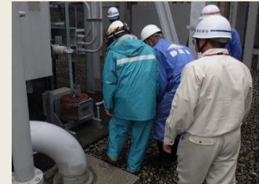
変圧器一相開放対策点検の様子
