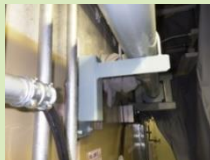
①配管サポート工事
