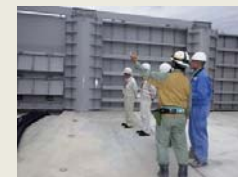
取水槽他の溢水対策 点検の様子
