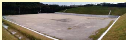
淡水貯槽工事前 (24年10月)
