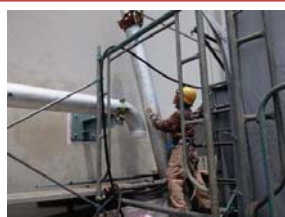
配管布設工事の様子
