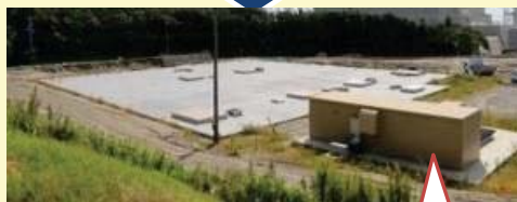
淡水貯槽設置完了後 (28年3月～)
