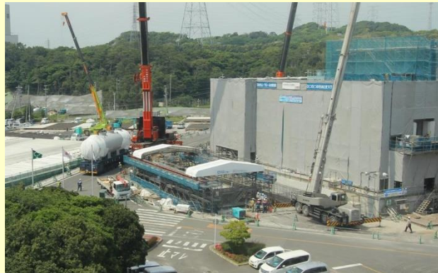
非常用電源設備用地下燃料タンク搬入(28年5月)
