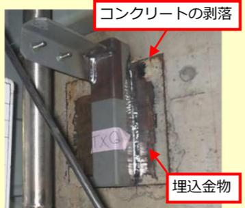
コンクリートの剥落が確認された埋込金物
