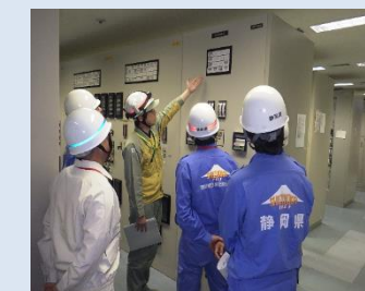
原子炉建屋水素濃度計点検の様子
