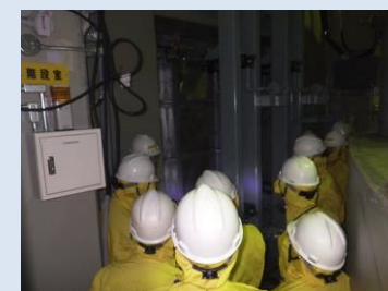
原子炉建屋ベント設備点検の様子
