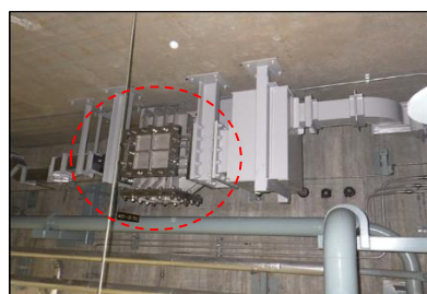
止水ダンパ設置後
