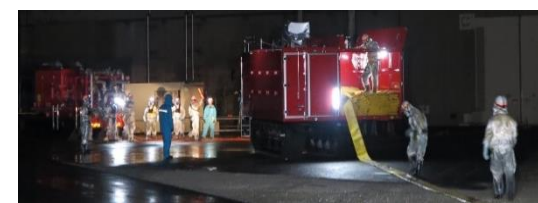
取水ポンプ車から注水ポンプ車までホース車でホースを敷設している様子
