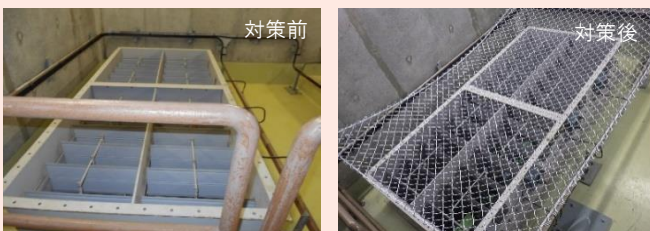
防護金網設置前後の様子
