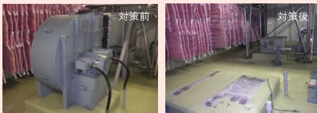
ディーゼル発電機空調給気ファン移設前後の様子
