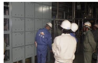
配管への防護鉄板取付状況の点検の様子
