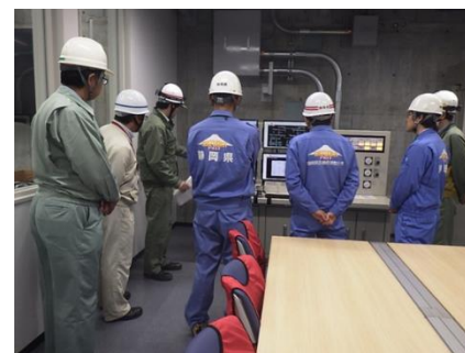
緊急時対策所機能確保対策工事点検の様子
