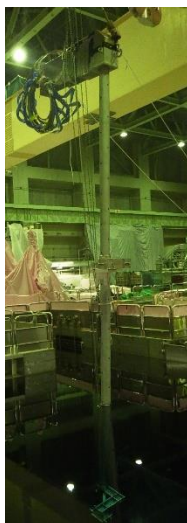
水位計検出器設置工事の様子
