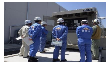
緊急時対策所の機能確保工事点検の様子
