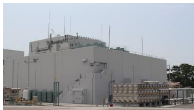
耐震の緊急時対策所（外観）
