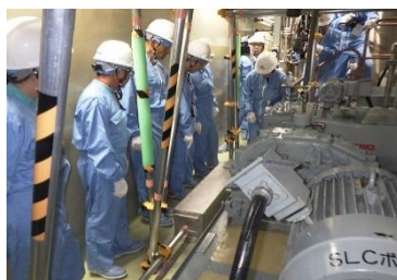
油内包機器からの漏えい拡大防止対策工事点検の様子
