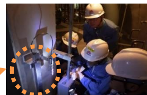
格納容器水位監視強化対策工事点検の様子
