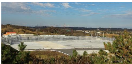
設備点検ヤード
