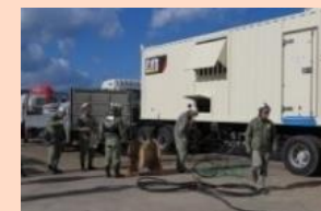
電源車操作訓練
