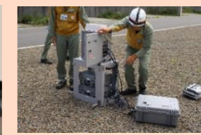
可搬型モニタリングポスト設置訓練
