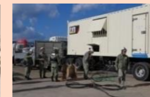
電源車操作訓練
