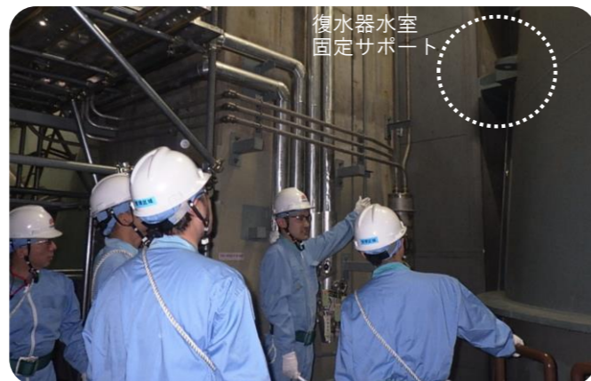
復水器水室固定サポート耐震補強工事の確認の様子
