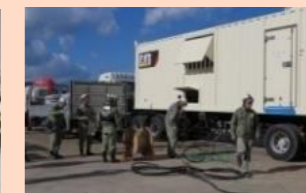
電源車操作訓練
