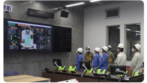
安全パラメータ伝送システム改造工事点検の様子
