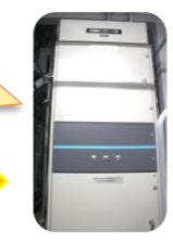
しゃ断器（電気の流れを入切します）
