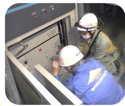
しゃ断器（電気の流れを入切します）
