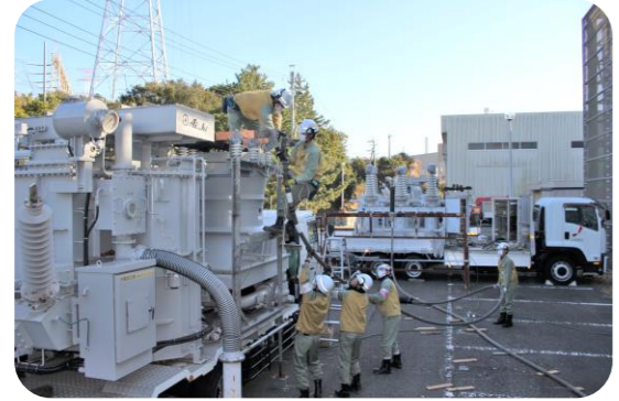
送電ケーブルの布設
