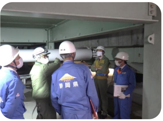
免震用オイルダンパーの現場確認状況
