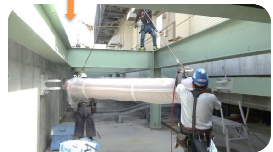
免震用オイルダンパー取替工事の様子
