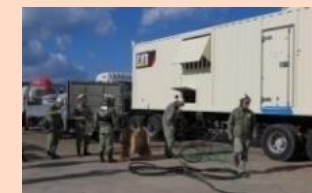
電源車操作訓練
