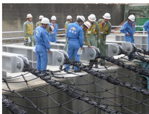
漂流物流入防止対策の点検の様子
