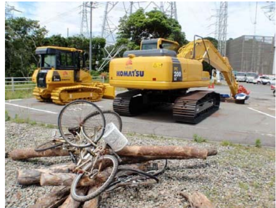
現場復旧訓練(重機によるがれき撤去)
