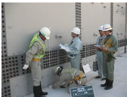
防波壁の壁部(たて壁)点検の様子
