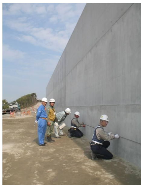
防波壁の壁部(敷地西側端部)点検の様子
