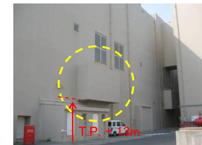
5号機 非常用ディーゼル発電機室排気口の例
