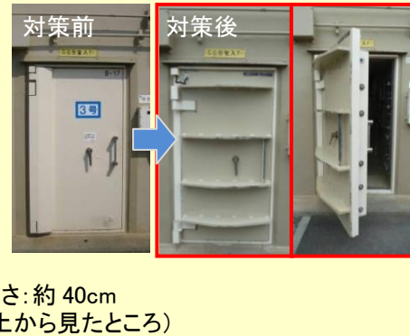
3号機 防水構造扉の例
