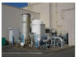
原子炉格納容器室素供給装置(1号機の例)
