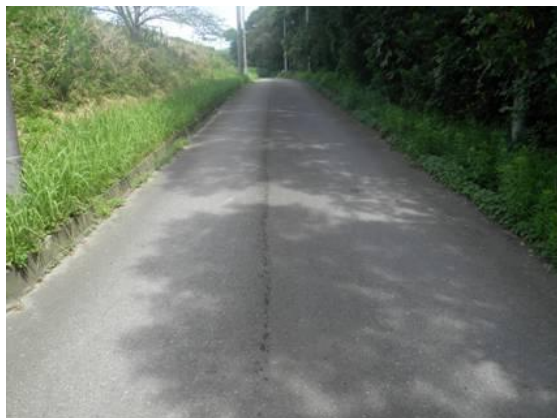
軽油が漏えいした跡(油除去作業実施前)
