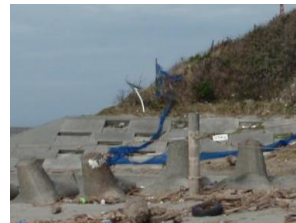
① 護岸設備 消波ブロック
