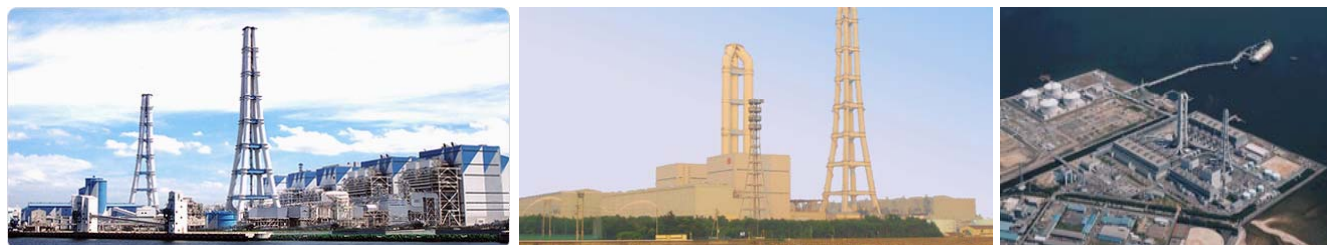
早期供給力確保のための電源やLNG基地 (写真は左から、碧南火力発電所、川越火力発電所・LNG基地)
