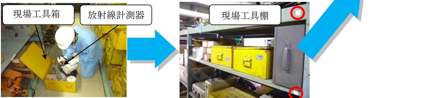
現場工具箱を開け、目視および放射線計測器による測定
