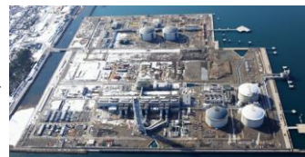
上越火力発電所
