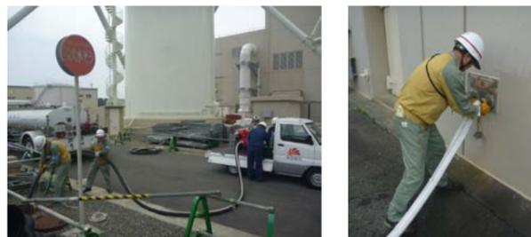
可搬式動力ポンプによる送水の実効性確認の様子
