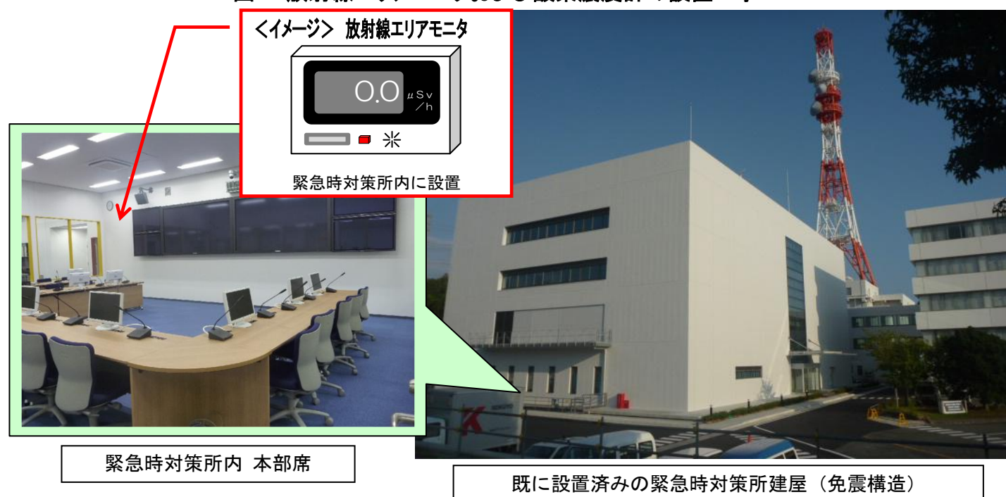
図1. 放射線エリアモニタおよび酸素濃度計の設置工事
