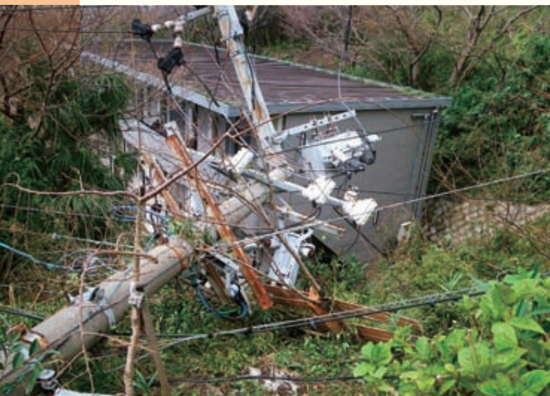
電柱折損の被害(愛知県蒲郡市)
