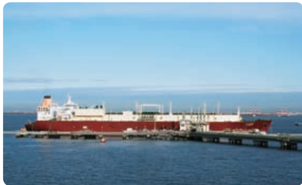
棧橋に着岸する大型LNG船
