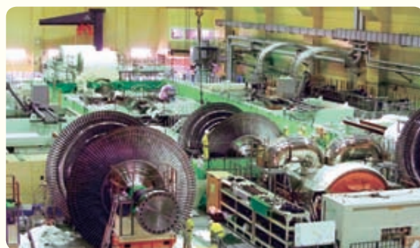
低圧タービン取替作業を行う5号機
