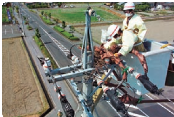
カラスの巣の撤去作業
