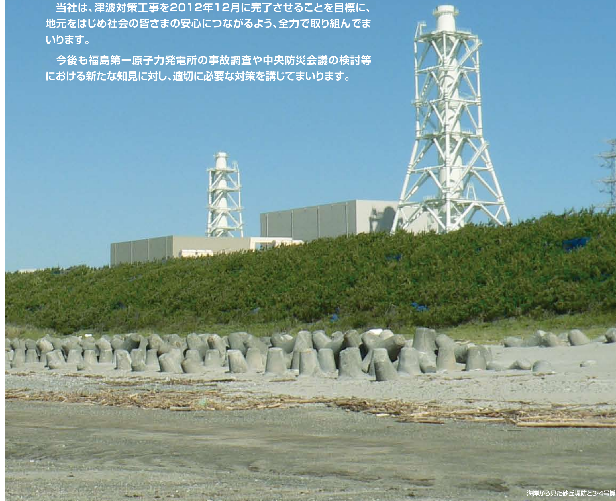
海岸から見た砂丘堤防と3・4号機
